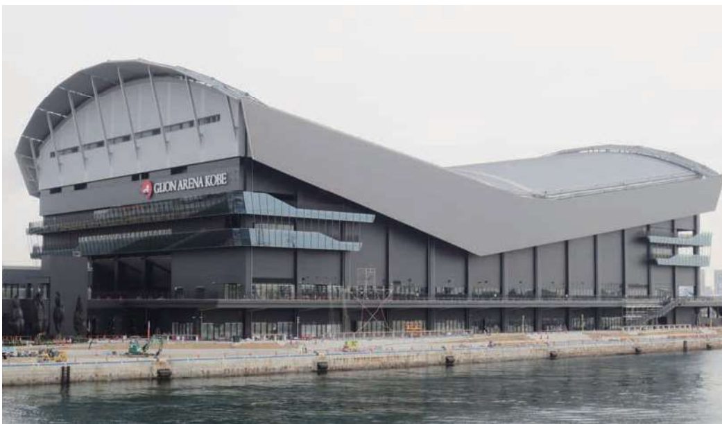
神戸港に建設中のジーライオンアリーナ神戸
